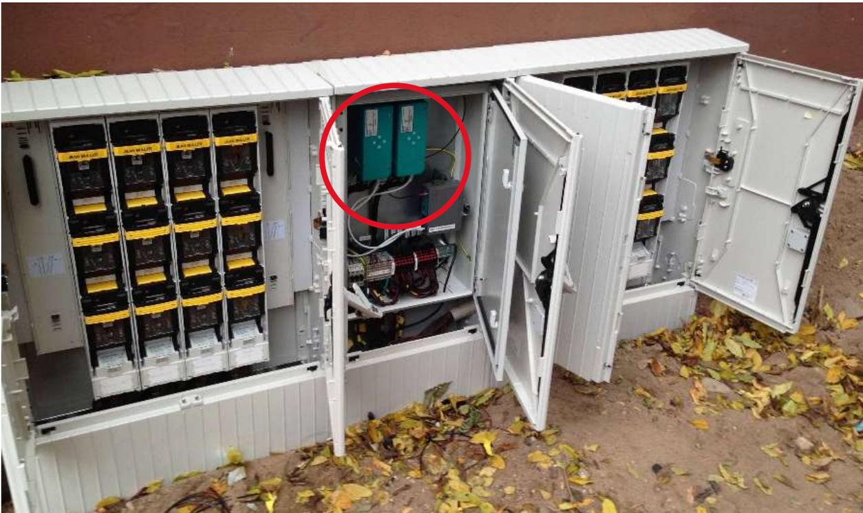
Abbildung 15: Nachrüstung von zwei Messkontrollern in bestehenden Schaltschränken (rot umkreist). [10]
